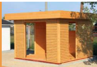
Coffrage de toit et de mur
