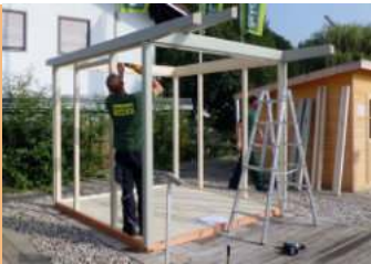
Montage de l'ossature autoporteuse
