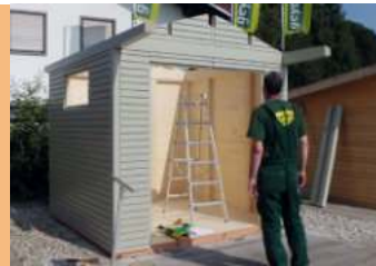
Montage des éléments muraux et éléments de pignon prémontés
