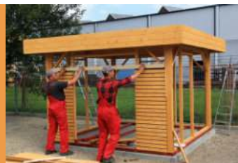
Montage du coffrage en losange
